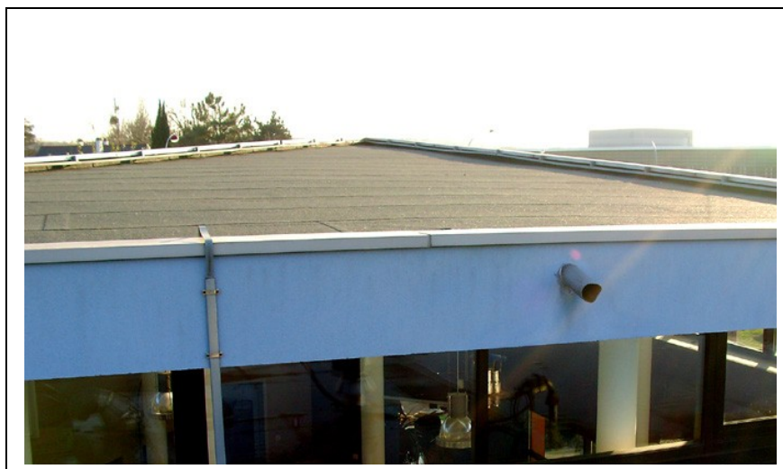
Surface de toiture-terrasse disponible (vue Nord)
