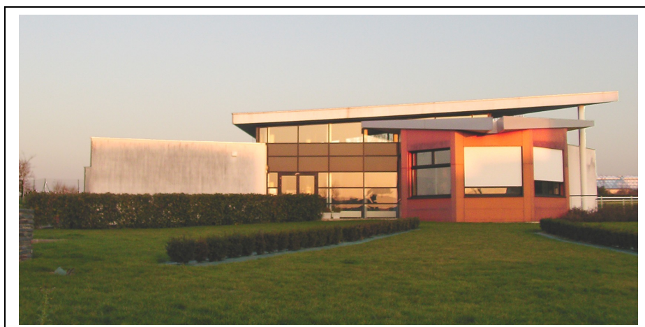
Vue actuelle de la toiture
