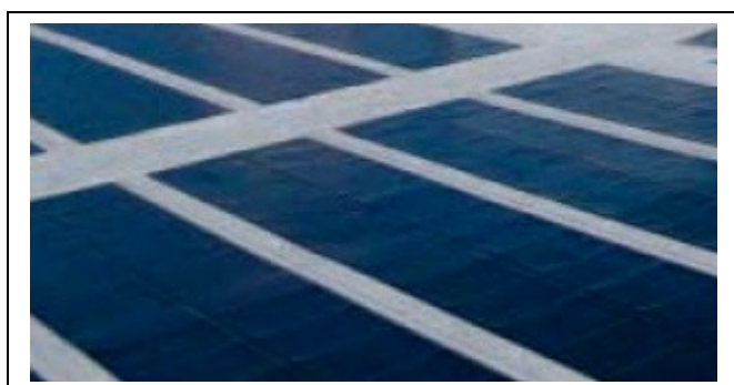
Exemple de membrane PV amorphe sur toiture terrasse (solution B, non visible depuis le sol)
